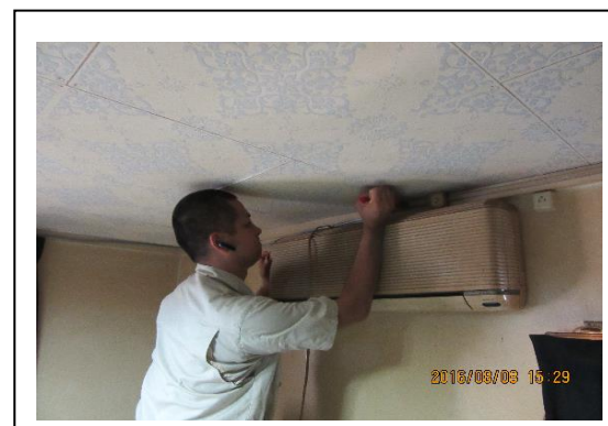
蛍光灯配線の固定
