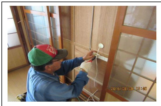
コンセント破損の取替
